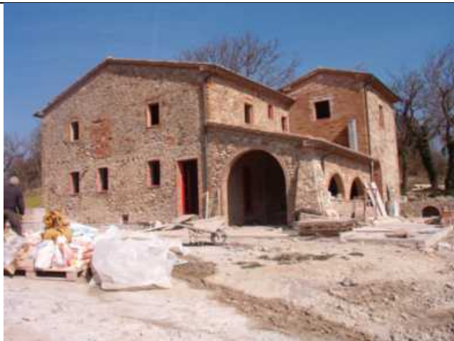
Foto del Podere durante i lavori di ristrutturazione
